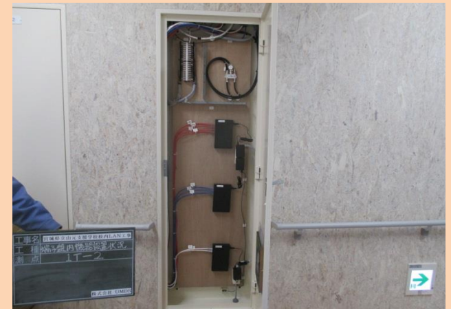
ネットワーク機器及び LANケーブル敷設状況
